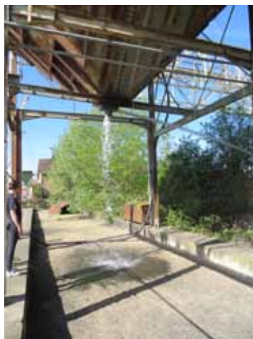
Pompage de l'eau de la Saône et deversement par la 1 ère trémie
