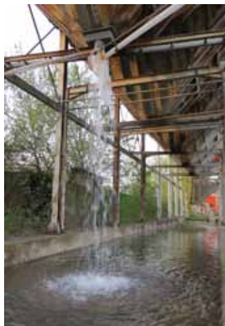
Remplissage de l'espace sous les trémies
