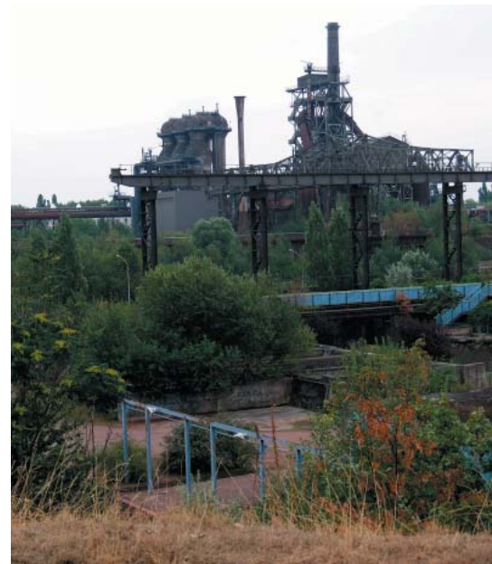
Les anciennes usines Thyssen dans le parc de Duisburg-Nord
